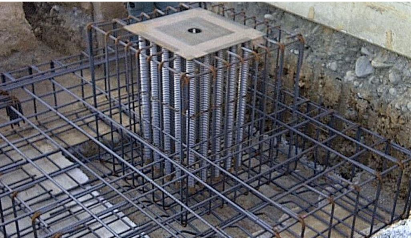
Piastra armatubo posizionata sulla gabbia di armatura
